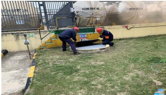
环保处置组检查水封井阀门开关状态
